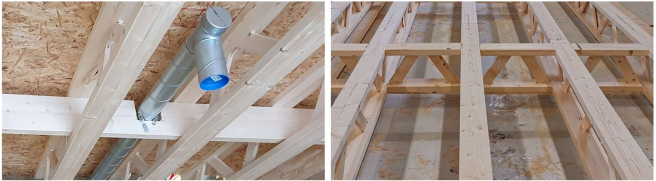
Kuva 3. Poikittaisjäykistys lujuslajitellulla sahatavaralla ja TK-jäykisteellä
